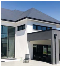
610m² großes Haus mit Fußbodenheizung und Warmwassererzeugung in Saint-Prest (Frankreich)
